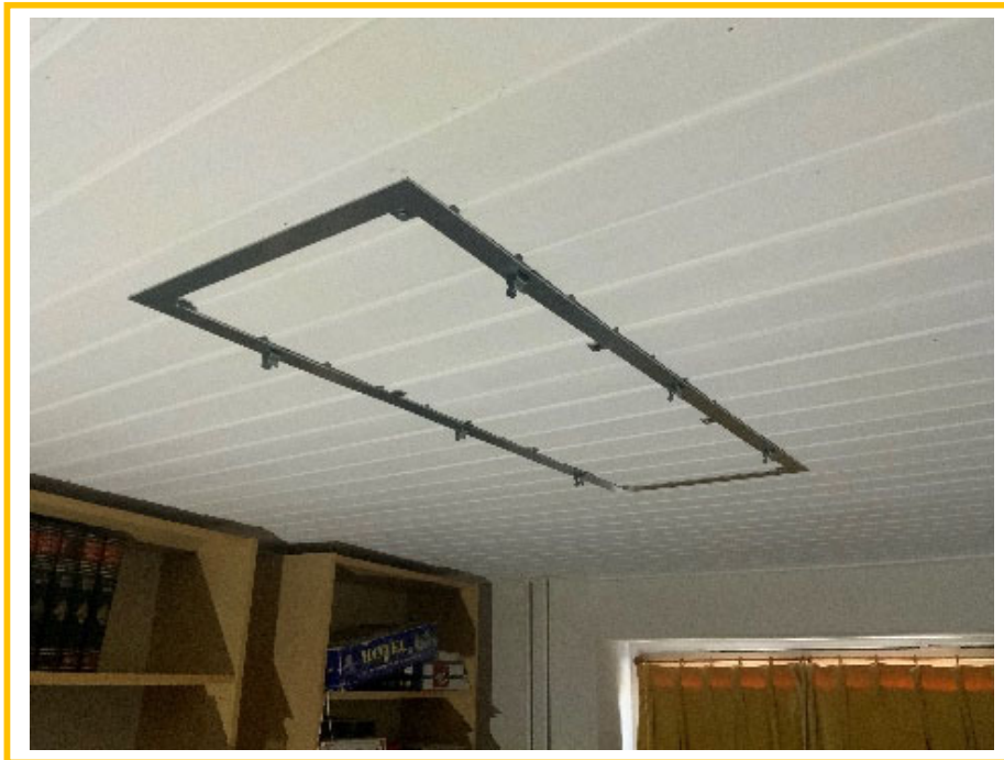
Voorbeeld van montage ophangframe aan het plafond.
